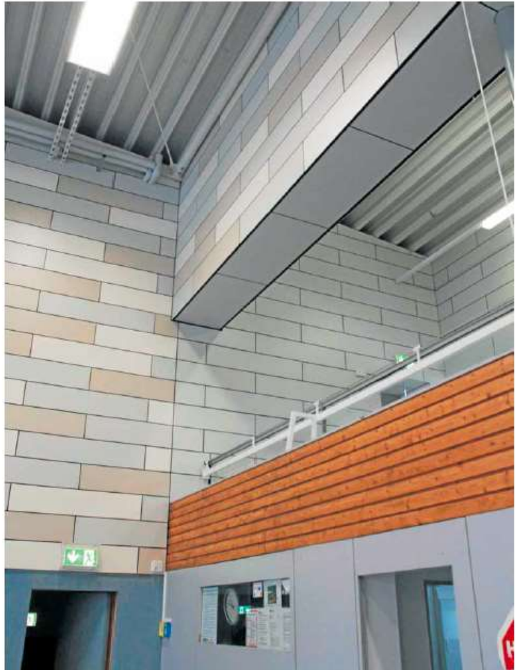
Energiesparende LED-Leuchten und Deckenstrahl-Heizkörper sind unter dem Dach angebracht. Für die Gestaltung der Innenwände und der Fassade ist Plattenmaterial verwendet worden. Fotos: Potthast
